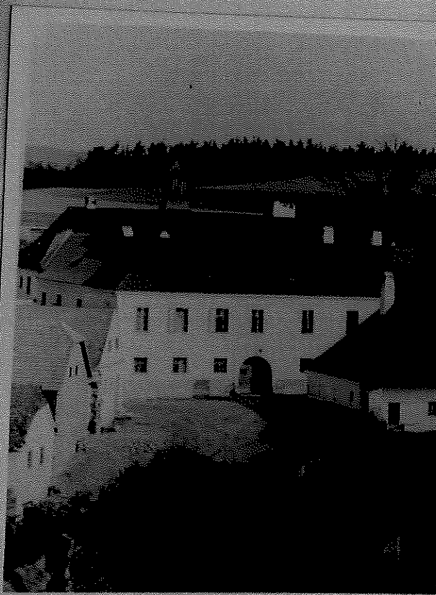
Die Schule im Schloßgebäude (3 Fenster rechts über dem Tore)
